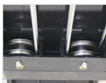
主平台下方的钢丝绳和滑轮。 Cable and pulley under main platform.
